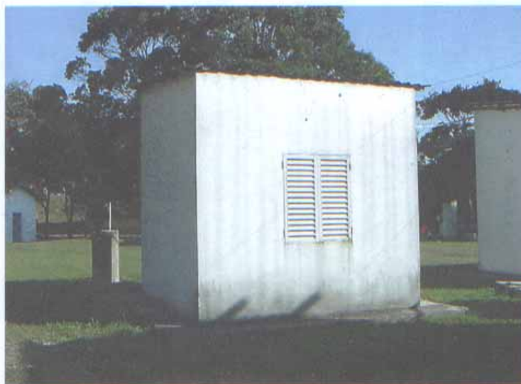
Foto 1 – Vista da face Norte (Fachada com a janela) de um dos Protótipos.
