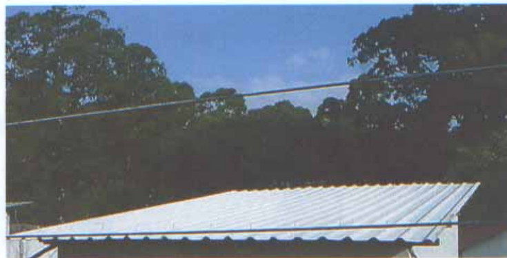
Foto 3 – Vista da cobertura com telhas com revestimento "EMC - Maxtherm #2000".
